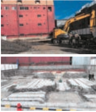
京都での工事の様子
